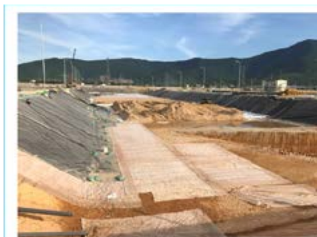
▲ Thi công hồ CN4
