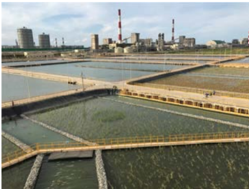
Hệ thống hồ sinh học & bãi lọc trồng cây kiểm soát sự cố, chỉ thị sinh học và xử lý bổ sung nước thải Công ty Formosa Hà Tĩnh do IESE chủ trì thiết kế, thi công (2017)
