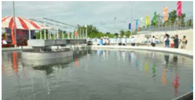
▲ Lãnh đạo TP. Cần Thơ tham quan hệ thống xử lý nước thải của KCN Trà Nóc 1
